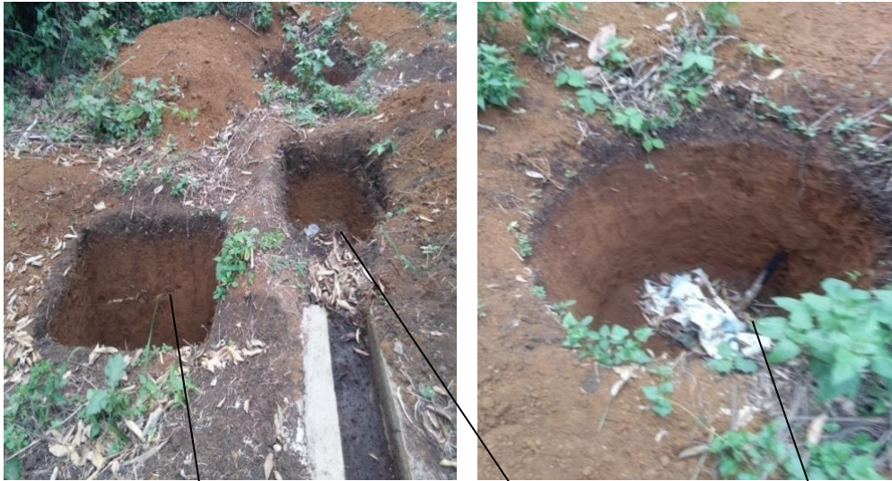
Gambar 12. Pembangunan Instalasi Pembuatan Biogas
