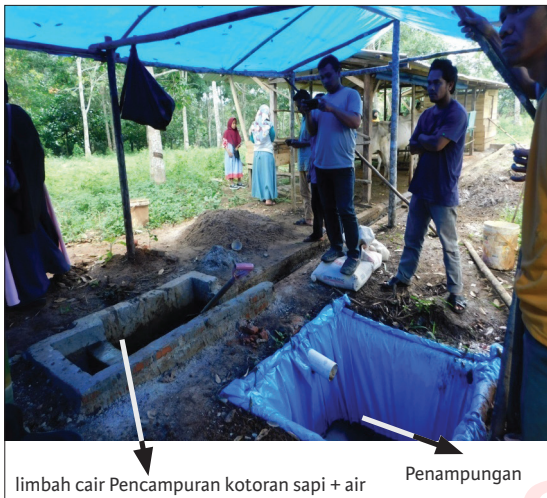
Gambar 19. Instalasi Biogas
