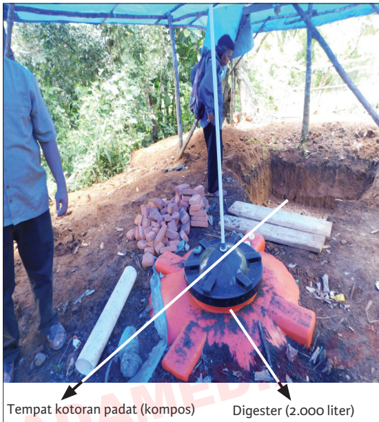
Gambar 21. Instalasi Biogas
