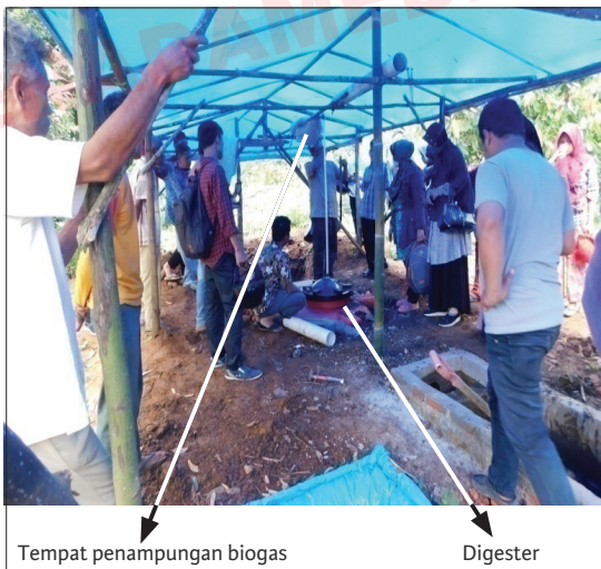
Gambar 20. Instalasi Biogas 1
