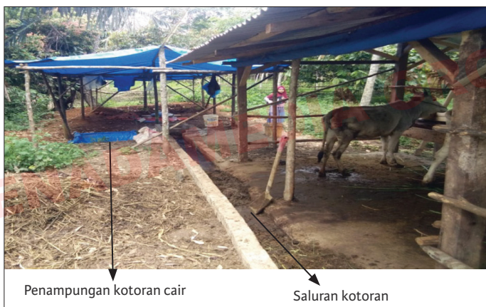
Gambar 23. Instalasi Biogas dengan Kandang Sapi
